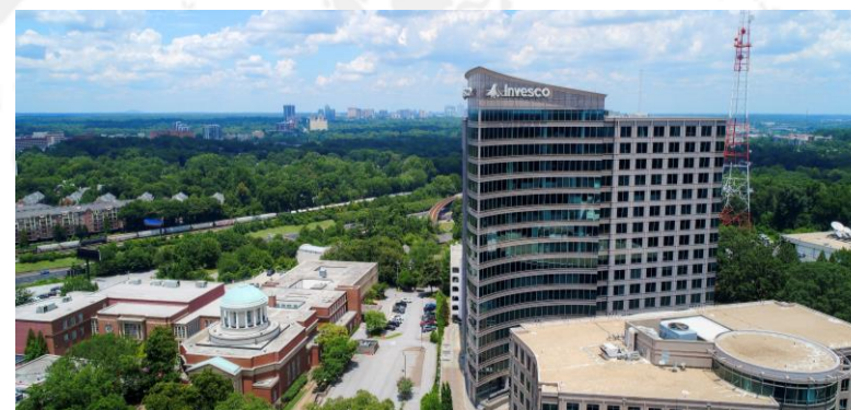
米国アトランタの本社オフィス
