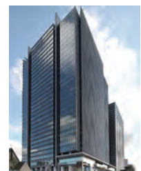
飯田橋グラン・ブルーム (東京都千代田区)
